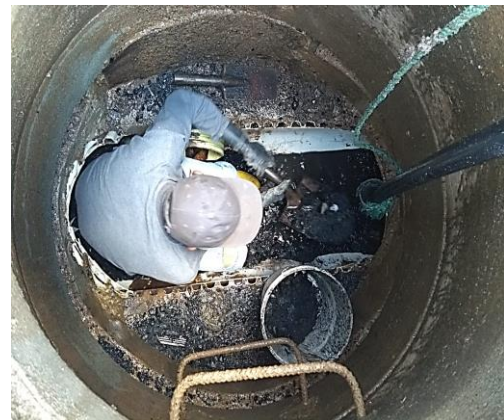
Ilustración 64 Mantenimiento sistema alcantarillado
