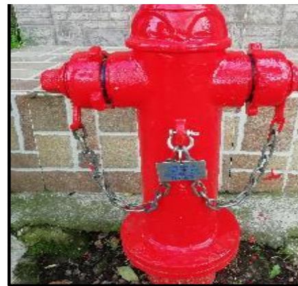
Ilustración 63 Mantenimiento de hidrantes
