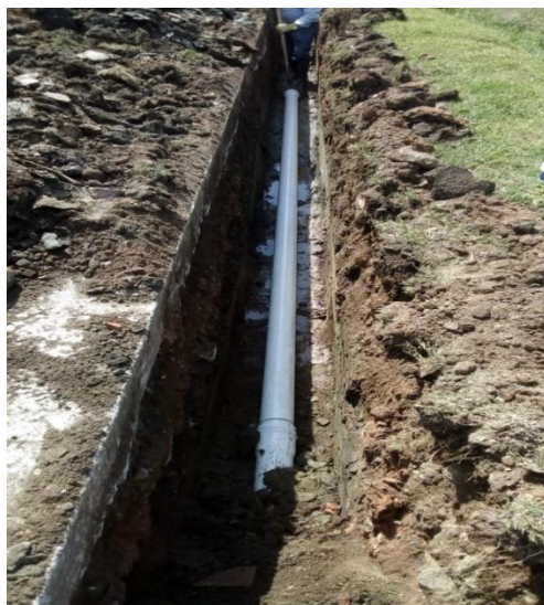
Ilustración 60 Conexión y puesta en funcionamiento del anillo de la planta de tratamiento de la Uchuval.
