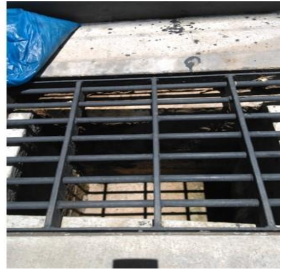
Ilustración 62 Rehabilitación de sumideros
