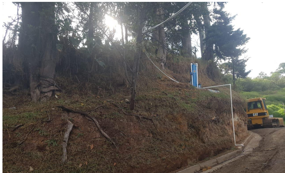
Ilustración 18 Planta potabilización Relleno y Planta de Orgánicos
