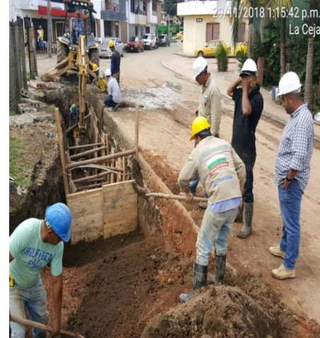
Ilustración 65 Optimización de colectores
