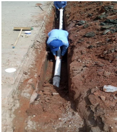
Ilustración 60 Conexión y puesta en funcionamiento del anillo de la planta de tratamiento de la Uchuval.
