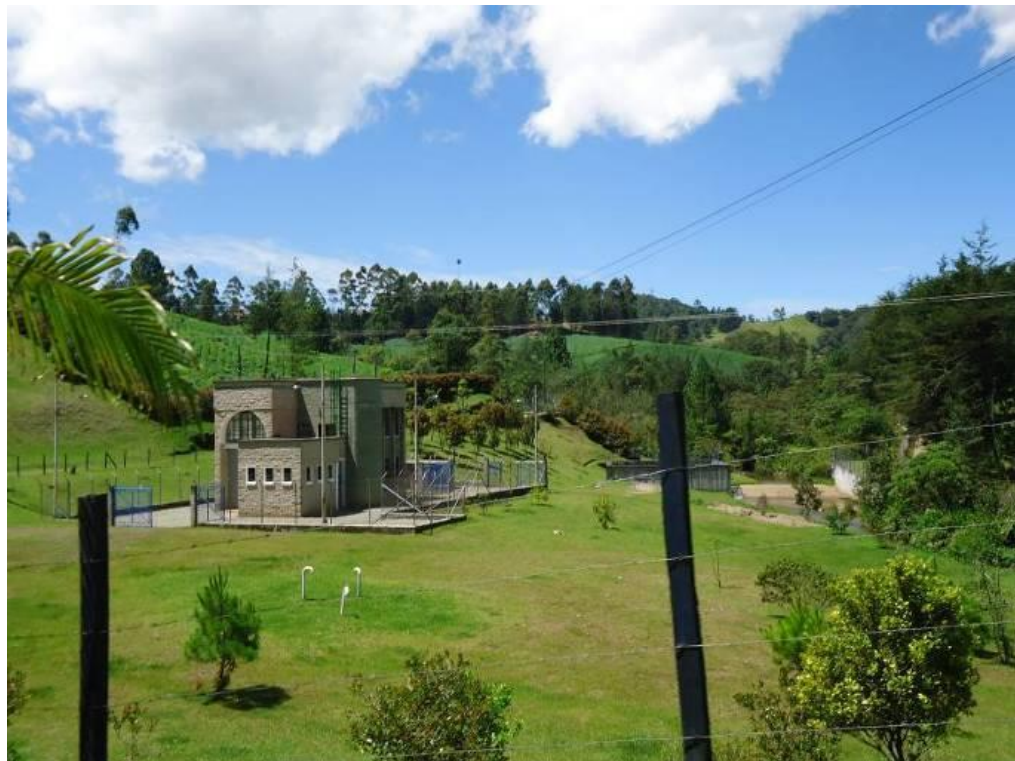
Ilustración 53 Sistema de bombeo sobre el río Pantanillo.
