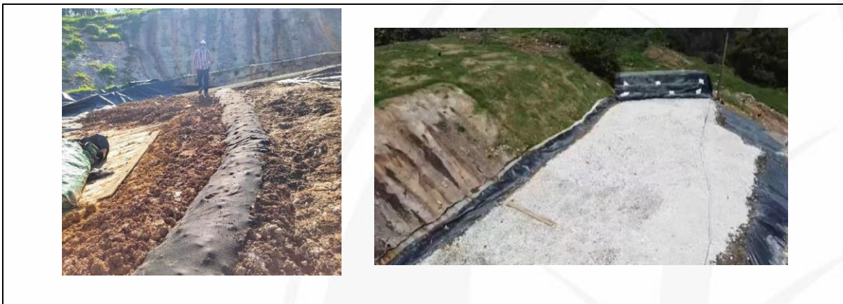
Figura. Antes y después de la rectificación de geometría en taludes en zona 5
