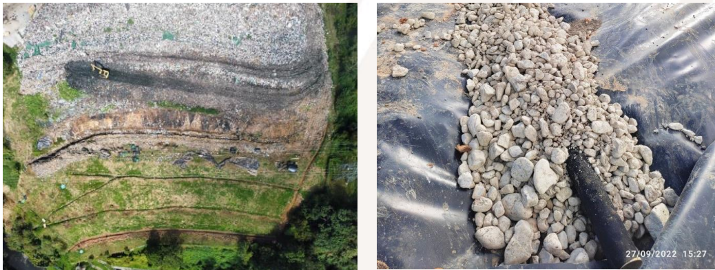
Figura. Antes y después de la rectificación de geometría en taludes en zona 5
